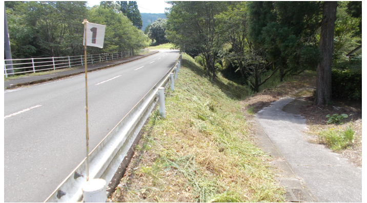
作業終了後 (NO.58=下塚田東下中線)
