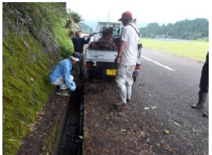
側溝泥上げ作業
