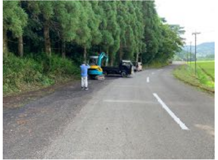
側溝清掃作業中（NO.51=萩之嶺下塚田線）
