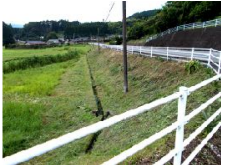
作業終了後（NO.58=下塚田東下中線）
