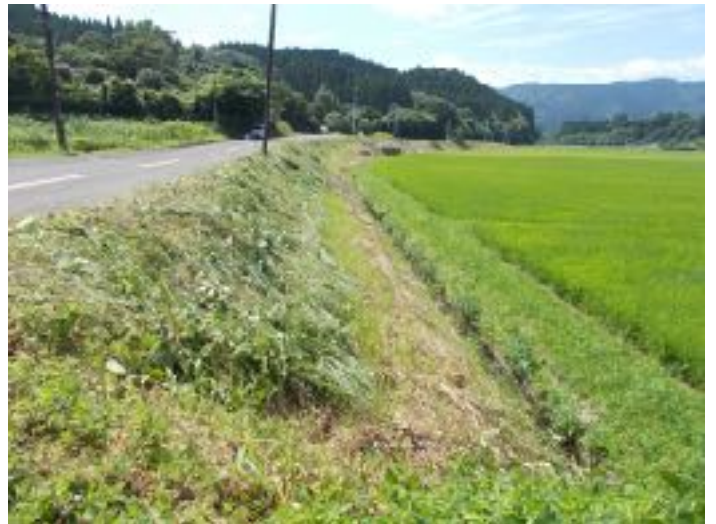
作業終了 (NO.51=萩之嶺下塚田線)
