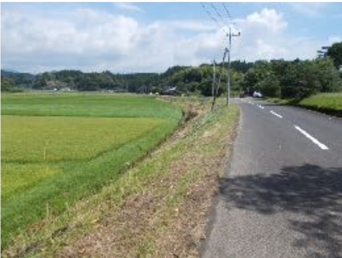
作業終了 (NO.51=萩之嶺下塚田線)
