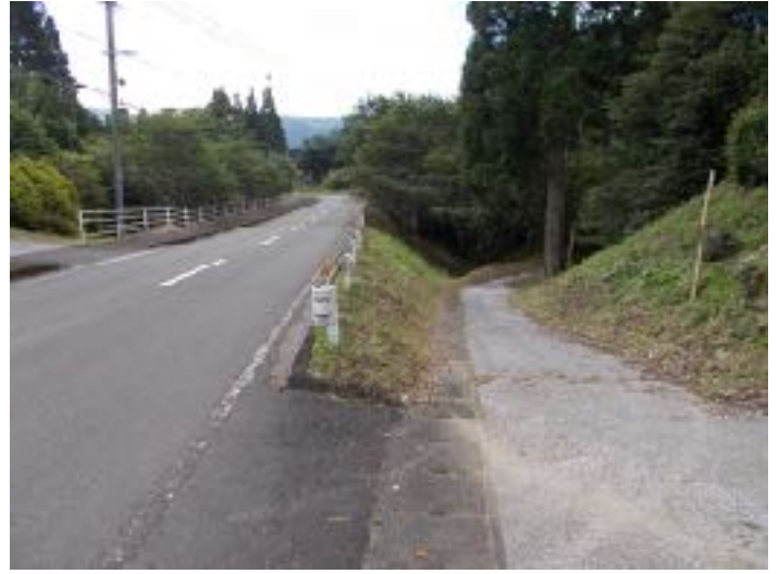
作業終了後 (NO.58=下塚田東下中線)
