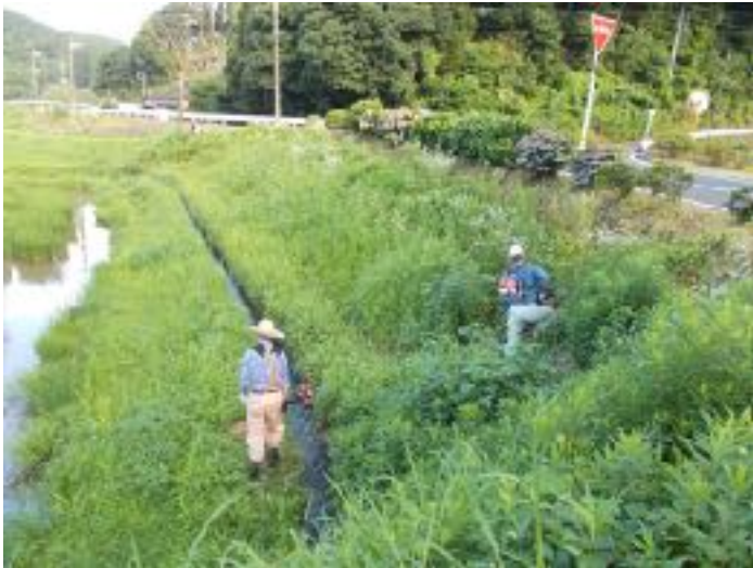
下大野班作業中 (NO.51=萩之嶺下塚田線)
